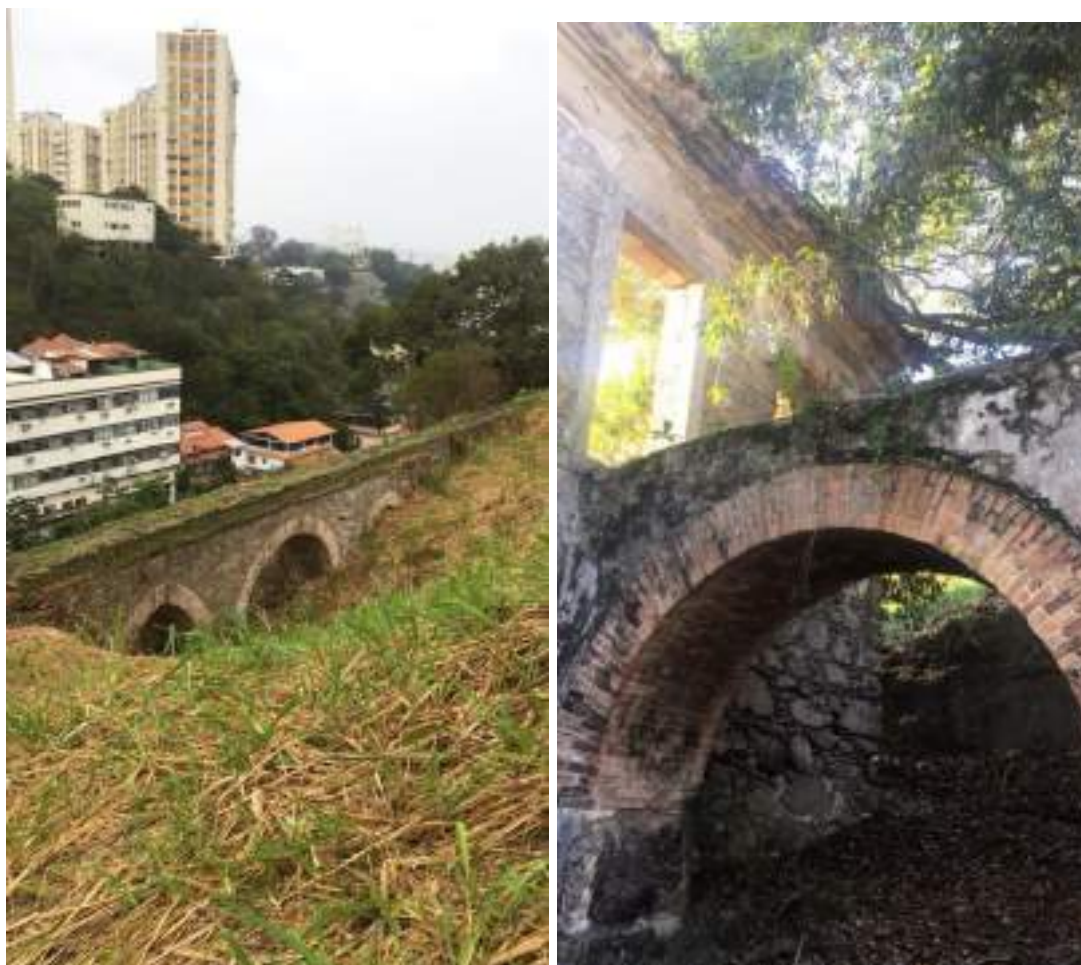
Figuras 12 e 13: Ruínas de construção associada ao sistema de abastecimento
